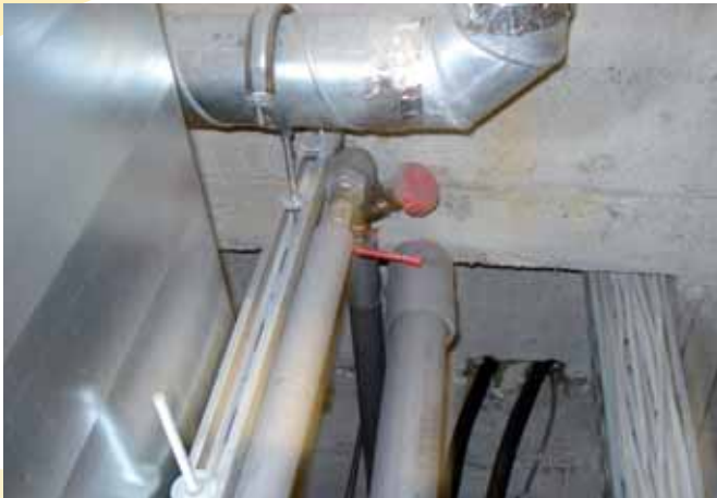
Versteckter Totraum in Heißwasserkreislaufsystem ermöglichte Legionellenwachstum – Quelle: OMFI.
